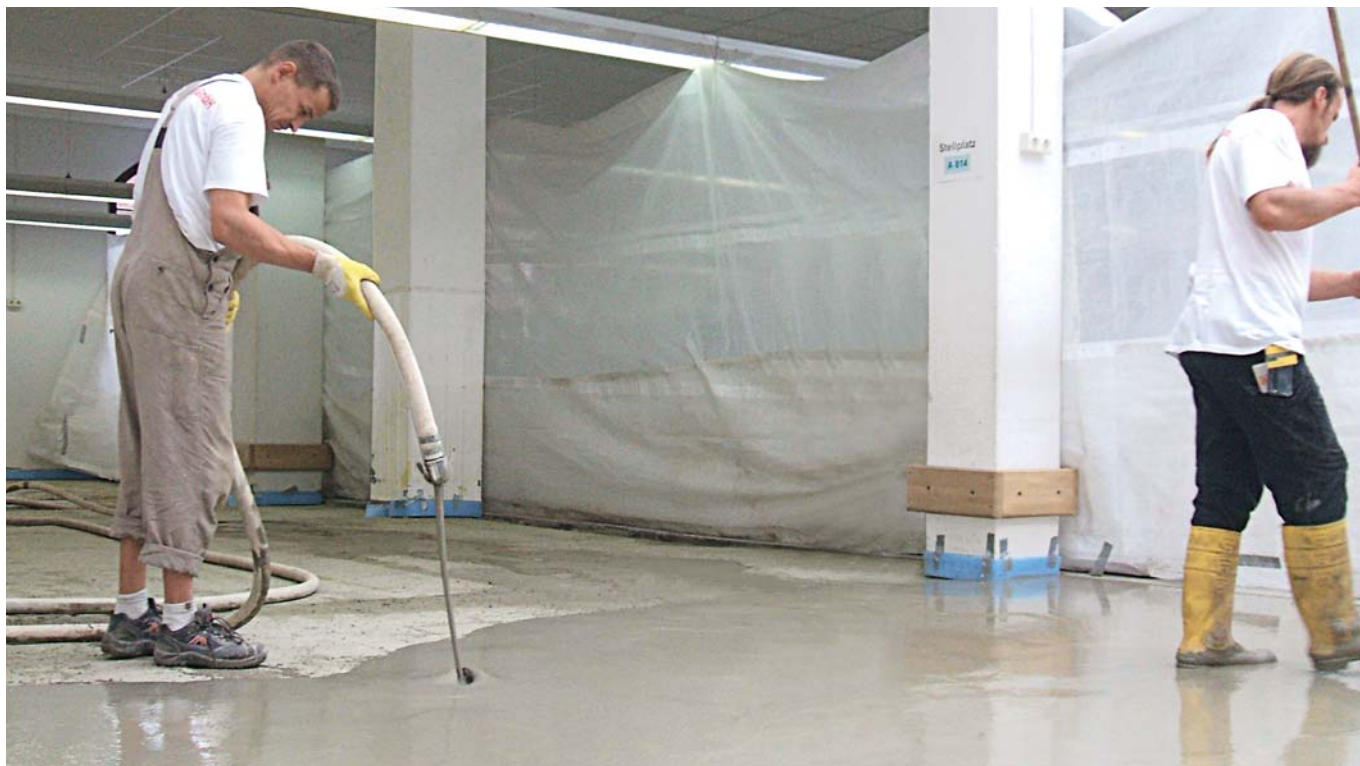
Главный почтамт в Галле / Рациональное машинное нанесение ремонтной стяжки RE 50
